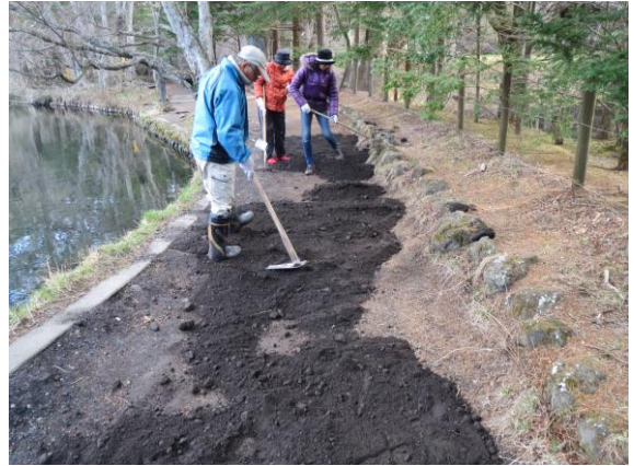
池の周囲に土を入れ、踏み固められた遊歩道を整備しています。
