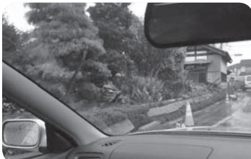
被災後1ヶ月。ブロック塀が倒れたままの状態
